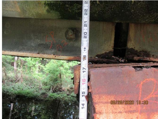
PHOTO #9 SWAY BRACING CORNER TO CAP TOP MEASUREMENT CLOSEUP= 17' 7]16"
