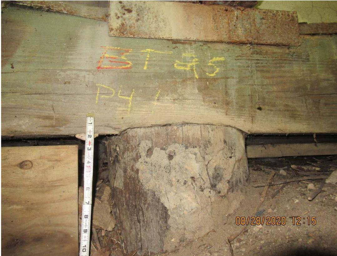
PHOTO #20 BT25 CAP OVER P4= 0.5" OF CRUSHING
