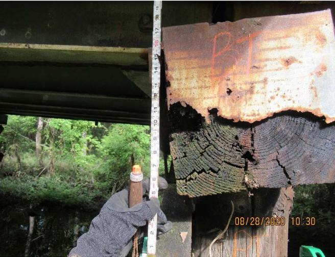
PHOTO #8 SWAY BRACING CORNER TO CAP TOP MEASUREMENT OVERVIEW= 17' 7]16"
